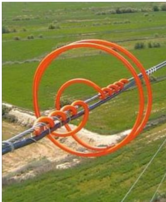
Dispositivo anticolisión en espiral
